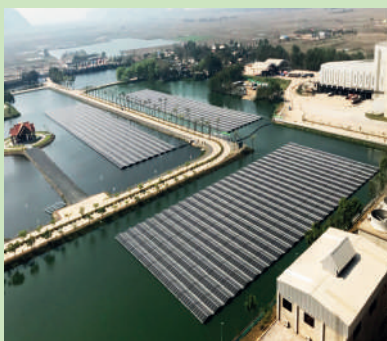
7.0 MW KCC Floating Solar, กัมพูชา
