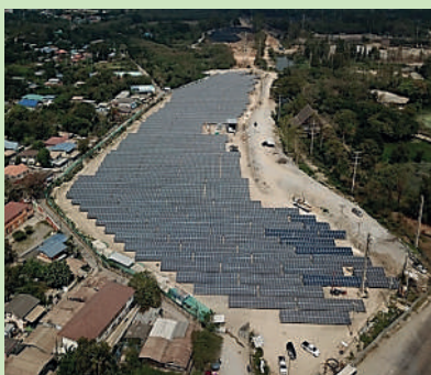
30 MW SKK1 Solar Farm, สระบุรี
