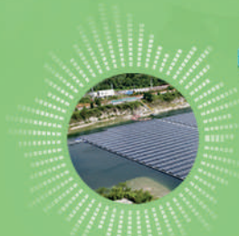
Solar Floating ระบบโซลาร์ลอยน้ำ
