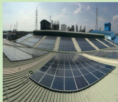
0.74 MW GSC Solar Roof, ระยอง
