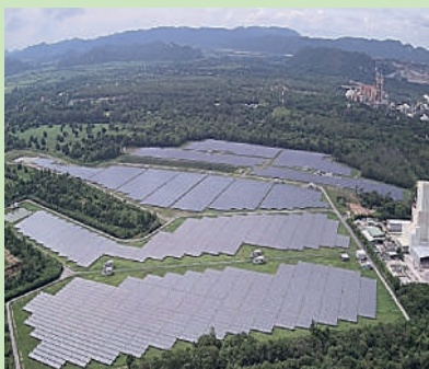
3.75 MW STS1 Solar Farm, นครศรีธรรมราช
