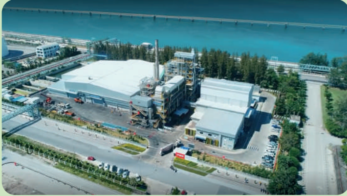
โรงงาน Maptaphut ECO Energy Power Plant กำลังการผลิต RDF 360 ตัน / วัน
