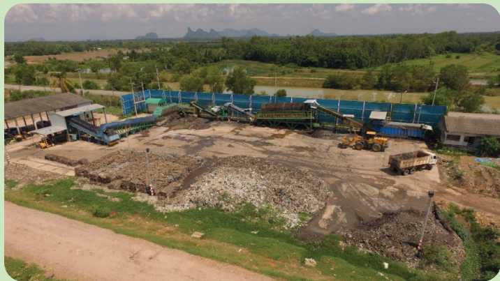
โรงงานคัดแยกขยะจากบ่อฝังกลบ เพื่อผลิตเชื้อเพลิง RDF เทศบาลเมืองพัทลุง กำลังการผลิต RDF 400 ตัน / วัน
