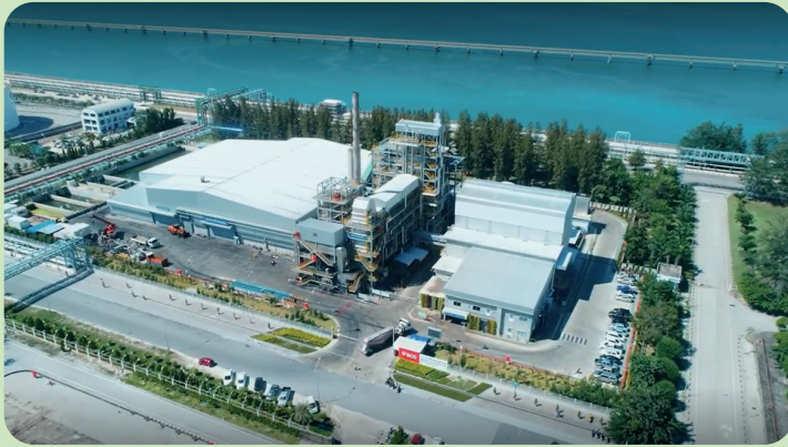
โรงงาน Maptaphut ECO Energy Power Plant กำลังการผลิต RDF 360 ตัน / วัน
