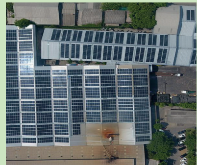
1.5 MW SRIC Solar Roof with 0.5 MWh Energy Storage, สระบุรี
