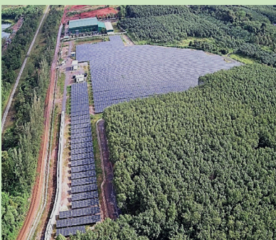
2.5 MW STL1 Solar Farm, สระบุรี
