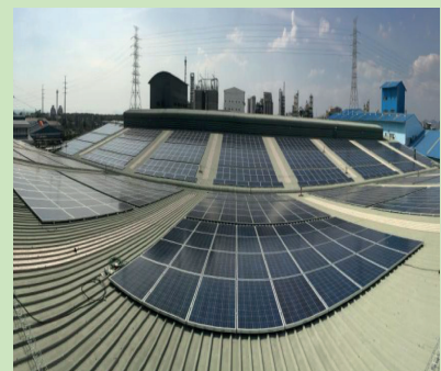
0.74 MW GSC Solar Roof, ระยอง
