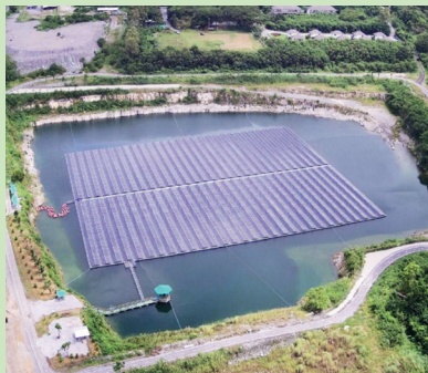
2.5 MW SKW Floating Solar, สระบุรี
