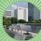
Solar Car Park ระบบหลังคาโซลาร์ สำหรับพื้นที่จอดรถ
