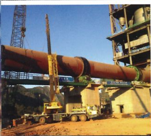
งานติดตั้งหม้อเผา (Installing kiln)
