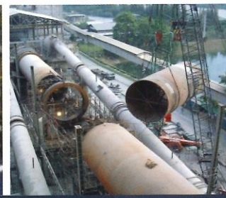
งานตัดและเปลี่ยนเปลือกหม้อเผา (Cutting and Replacing kiln shell)
