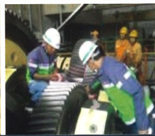
งานติดตั้งเกียร์ (Installing large gear)
